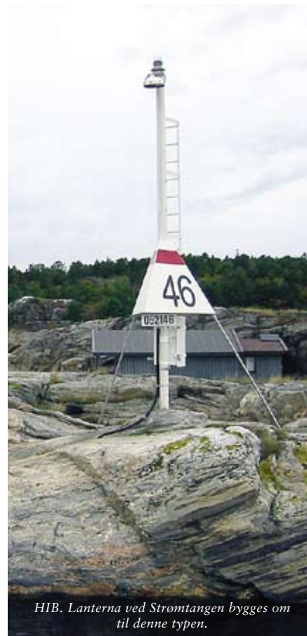
Fyrlykt på betongsøyle. Eks. på fyrlykt som skal etableres på Krabberødbåen.
